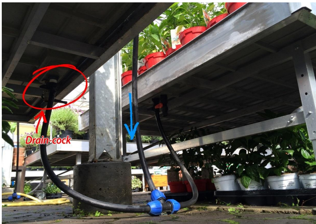
Sobre: Sistema de riego debajo de las mesas
